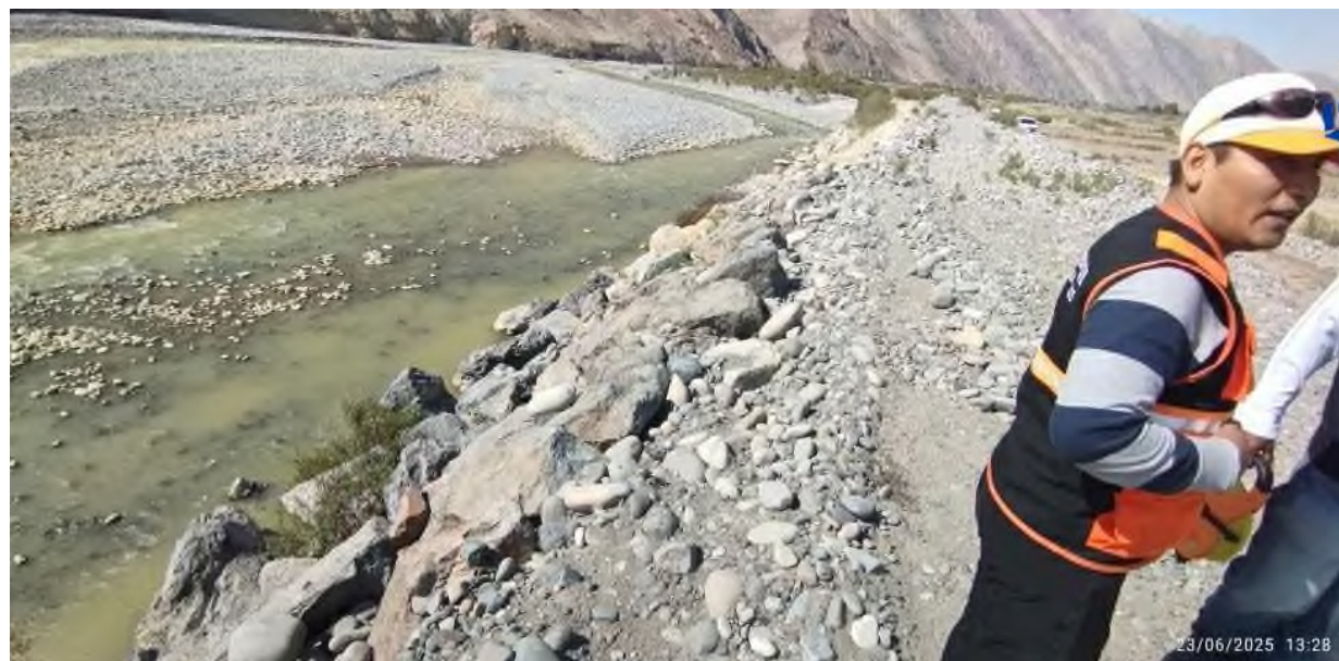
FIGURA N°03: TRAMO 03 FIN DE ACTIVIDADES E SECTOR CHECA, PERDIDA DE ENROCADO DE PROTECCION EN TALUD
