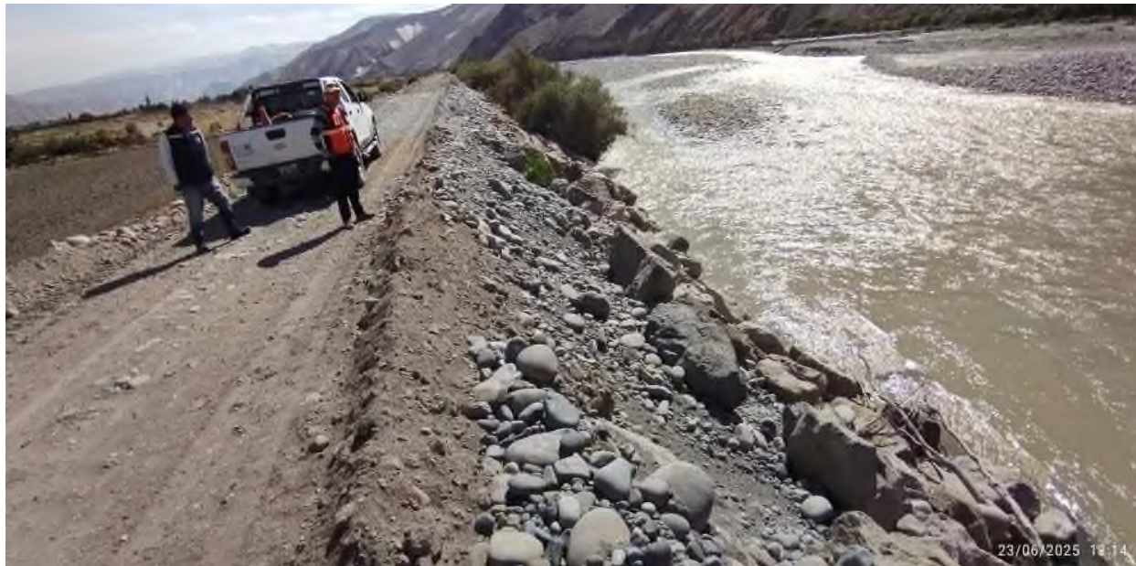
FIGURA N°02: TRAMO CRITICO 02, TALUD Y BASE DE TALUD SOCAVADOS, ENROCADO EN BASE DE TALUD Y TALUD EROSIANADOS, PERDIDA DE ENROCADO DE PROTECCION
