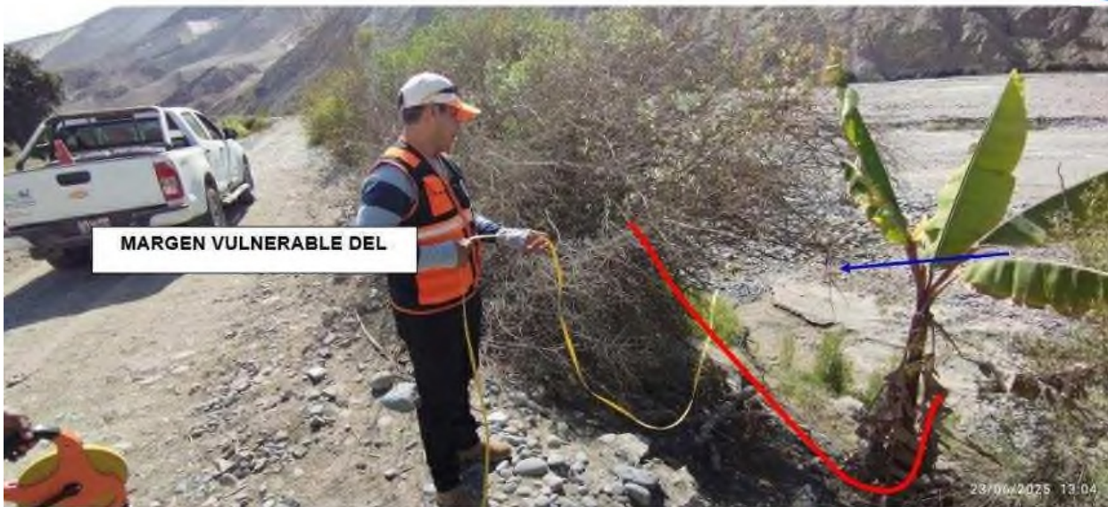
FIGURA N°01: TRAMO 01 INICIO PUNTO CRITICO, TALUD SIN ENROCAMIENTO DE PROTECCION
